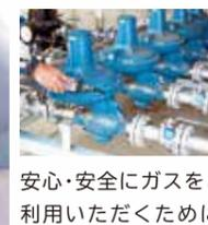
安心・安全にガスをご利用いただくために、定期的なガス貯蔵量点検、入荷状況の確認、警報装置の作動検査、各種設備のメンテナンスなどを実施しています。
