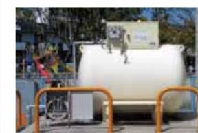
LPガスを貯蔵するバルク貯槽やガスメーターなどの供給設備と、煮炊き釜やコンロ・暖房機器・発電機などの消費設備をセットで準備。地震や津波などの大規模災害に備え、病院や大学に設置しています。電気や都市ガスの供給が止まった状況でも、LPガスによるエネルギー供給を安全かつ迅速に行うことができます。
